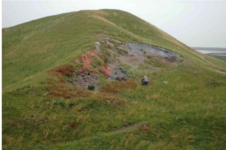
Travaux de lutte contre l'érosion réalisés par le CELRL – Cliché J.-Ph. Siblet
